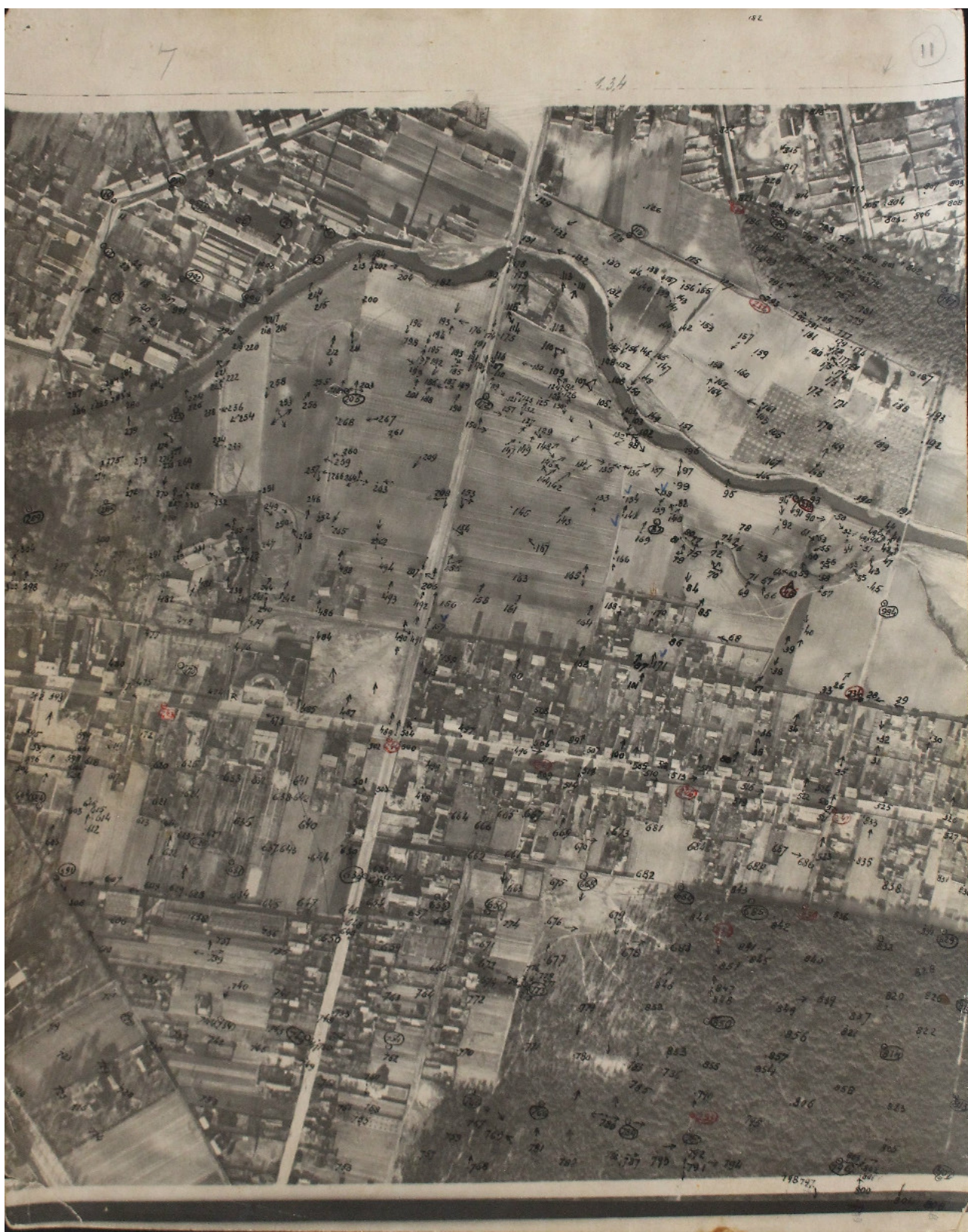
Zbiór kartograficzny, sygn. 707. Skrzyżowanie obecnych ulic prez. I. Mościckiego - J. Mireckiego i Nowowiejskiej - B. Głowackiego - widoczny budynek Banku Polskiego.
